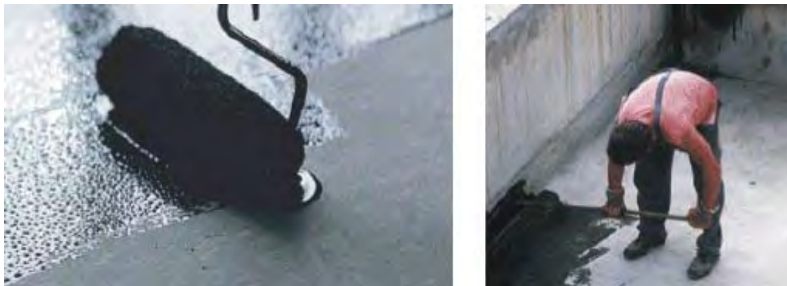
Рис. 5 Нанесение праймера
