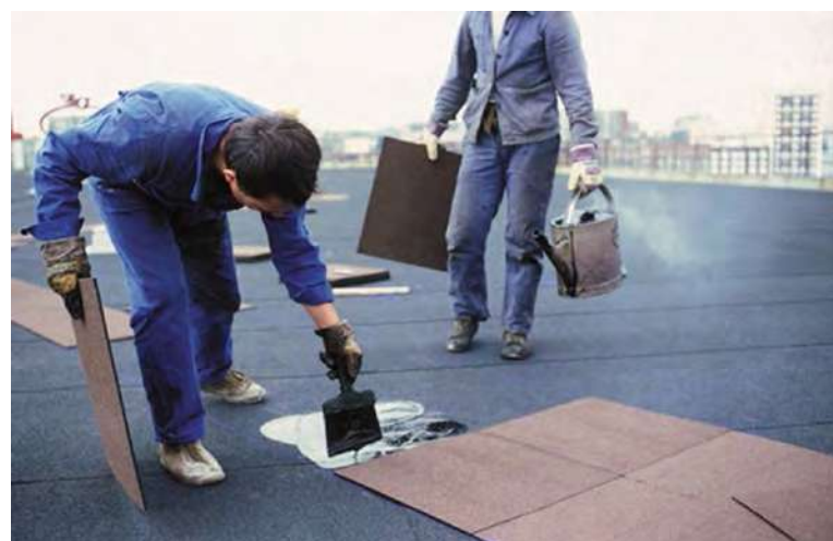
Рис. 12 Укладка плиток Dalle Parcours
