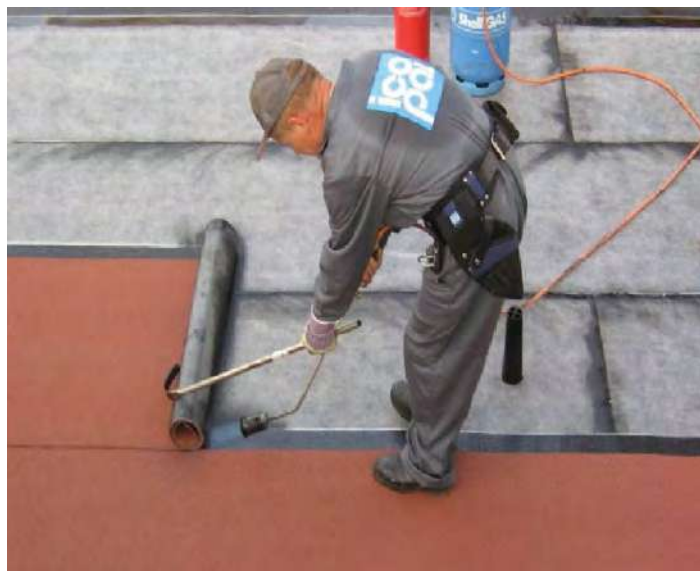
Рис. 13 Укладка верхнего слоя материала наплавлением
